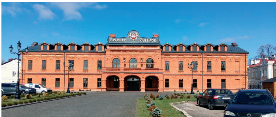
Rys. 9. Budynek po kasynie wojskowym w Hrubieszowie
