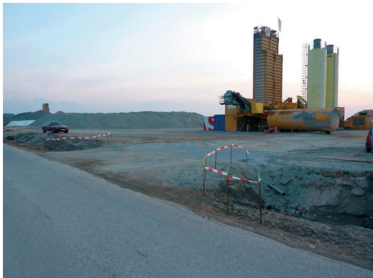
Rys. 2. Ogólny widok poligonowego stanowiska badawczego w Boczowie (budowa autostrady A2)
