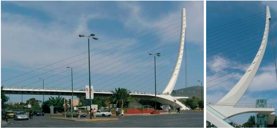
Rys. 3, 4. Kładka w kierunku terenów Olimpiady w Atenach – widok ogólny i zbliżenie na pylon. Źródło: www.structurae.net/structures/katehaki-bridge [dostęp: 26.01.2016]
