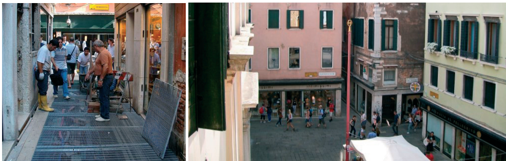
Fot. 31,32. Funkcjonowanie kameralnych przestrzeni uliczek i placów pieszych Wenecji. Z lewej: tymczasowa nawierzchnia z krat pomostowych umożliwiająca ruch pieszych podczas trwających pod spodem prac przy instalacjach podziemnych (12 września 2008 roku). Z prawej: Widok z góry na Campo San Lio (26 sierpnia 2012 roku) Zdjęcia: Hubert Trammer
